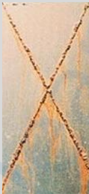
Korrosion nach 1450 Stunden
