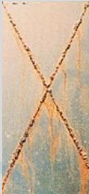
Corrosion après 1450 heures
